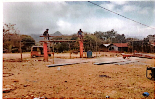
foto 4: sustitucion del porton del establecimiento
