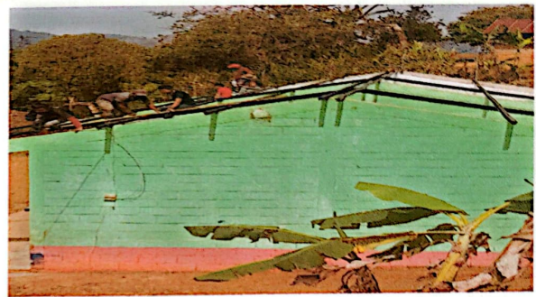
foto 2: sustitucion de laminas
