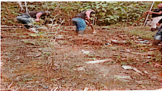
foto 3: empezando con la construccion del baño
