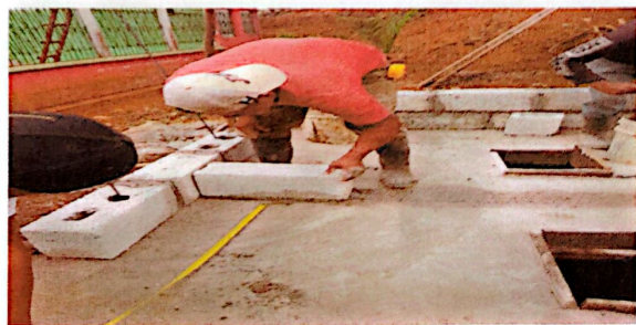
foto 6: empezando la colocacion de bloc de baño
