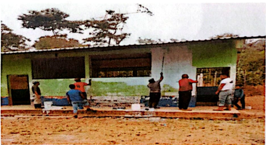
foto 5: inicio con la pintura del modulo 1-2 y la direccion
